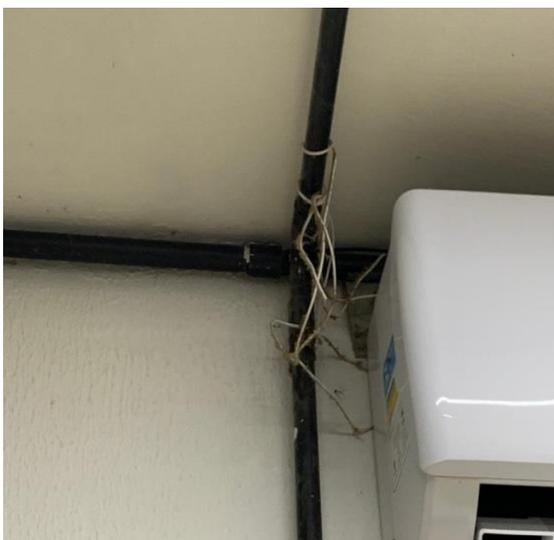
*Figura 5 - Fiação exposta na tampa*
