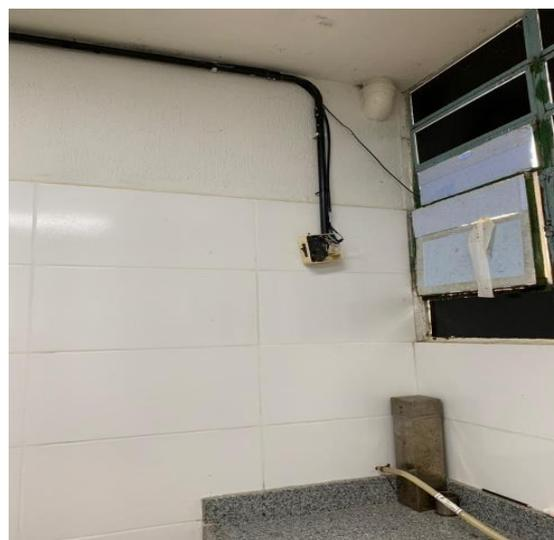
*Figura 6 - Caixa de energia sem tampa*
